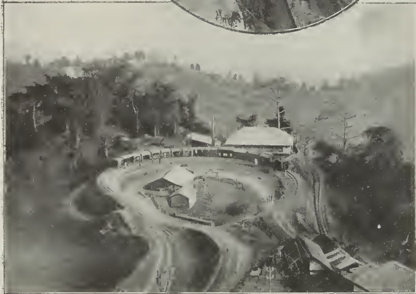
Tren atravesando una de las selvas milenarias del Himalaya. — La estación de Reversing; en ella se ven las muchas curvas que describe la vía para escalar la montaña. — Una de las muchas curvas de la línea, cerca de la estación de Chimbatti; en ella se ve un tren en marcha que describe casi un circo perfecto. (De fotografía de Hatin, Trampus y C.)
